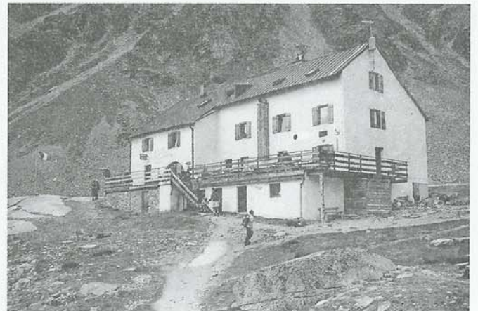
Il rifugio Serristori (2721 m) nella vallata di Solda.
